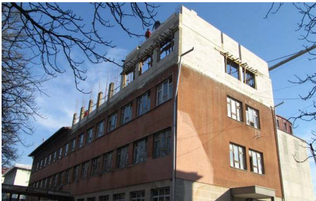
Слика 7: Почетак реконструкције зграде Основног суда у Приједору
